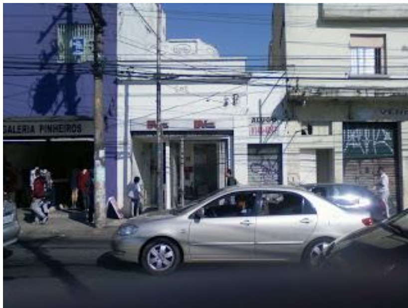
Figura 6 - Degradação na rua Theodoro Sampaio - Fiação amostra e má conservação de fachadas
