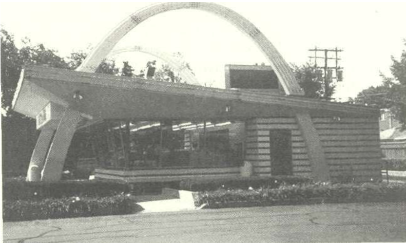
Foto 2 - Detalhe dos "arcos com formato de arco-íris", com iluminação em néon.
